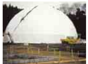
▲恐竜館のドームを建設中
